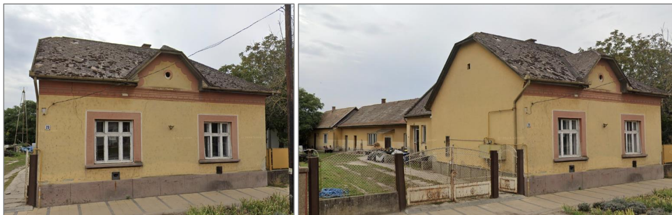
Bajcsy Zsilinszky út 35 szám. alatti helyi védelemre javasolt épület (forrás: Google Earth)
